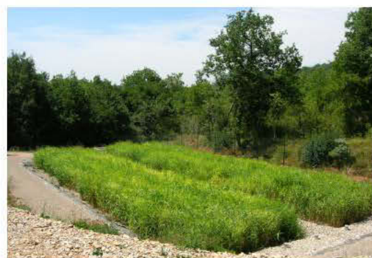
Filtre à sable planté de roseaux
