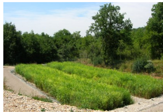
Filtre à sable planté de roseaux
