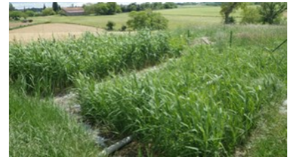
Filtre à sable planté de roseaux
