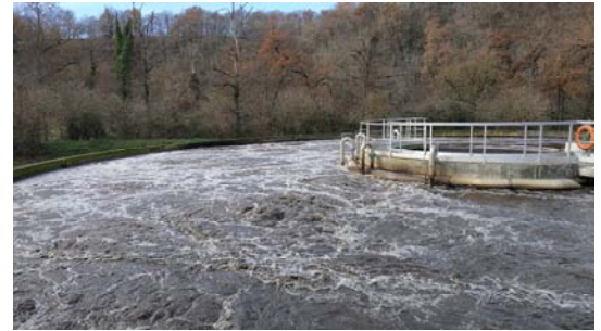
Bassin d'aération d'une station d'épuration à boues activées
