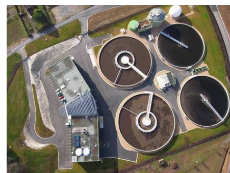
Vue aérienne d'une STEU à boues activées
