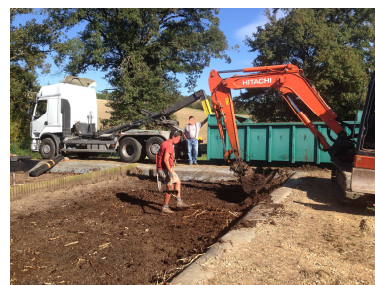
Curage des boues d'un filtre planté de roseaux
