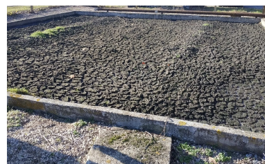
Lit de séchage de boues
