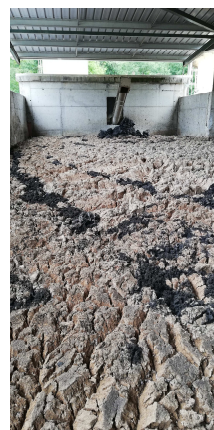
Stockage de boues chaulées
