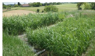
Filtre planté de roseaux
